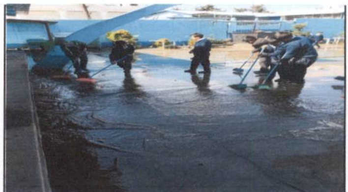
Foto 4: Reparación de Drenajes para fluido de aguas pluviales
