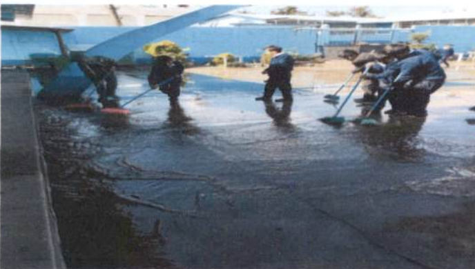
Foto 3: Reparación de drenajes para poder sacar las aguas pluviales del patio de la escuela ya que en tiempo de invierno presenta riesgo para los niños.
