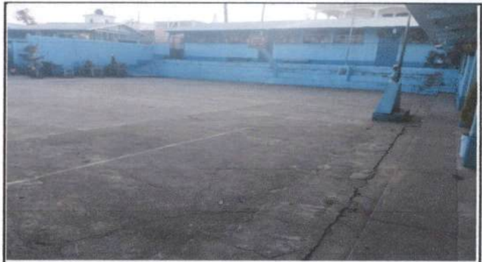
Foto 2: Reparación del patio de la Escuela por acumulación de agua en tiempo de invierno
