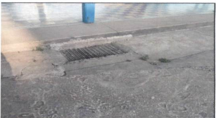
Foto 4: Reparación de Drenajes para fluído de aguas pluviales
