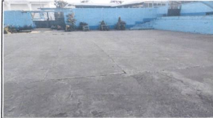
Foto 1: Reparación del patio de la Escuela por agrietamientos casados por los terremotos
